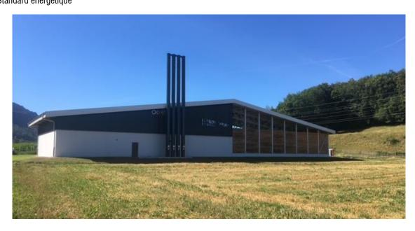
Réalisation d'une centrale de chauffage thermique à bois avec la mise en place de trois chaudières à bois (550) et d'une chaudière à gaz (1'750 kW)en appoint. Cette nouvelle centrale remplace l'existante.
