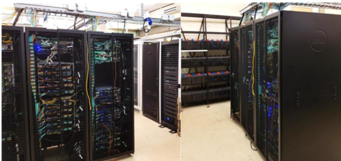
Suite au vieillissement du système de climatisation du local serveur, le projet prévoit une rénovation du Datacentre de Batelle mandatée par l'Office des bâtiments. Après une phase d'étude préliminaire, un couloir froid a été mis en place afin d'éviter la déperdition et d'optimiser la climatisation devant les racks dans le local.
